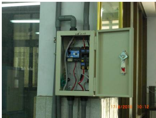
圖 1 電氣開關箱未設隔板
